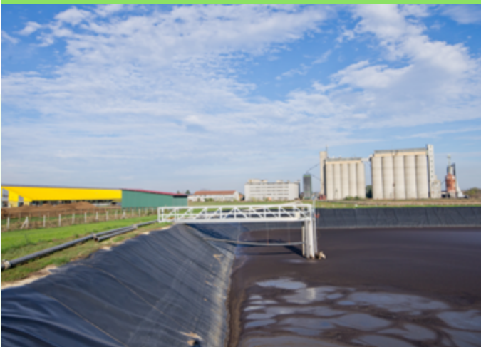
► Ilustración 53. Instalación exterior de almacenamiento de estiércol.
